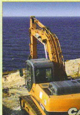
En portada obras no contorno do faro de San Cibrao. (fotografía de Alberte S.R.)
