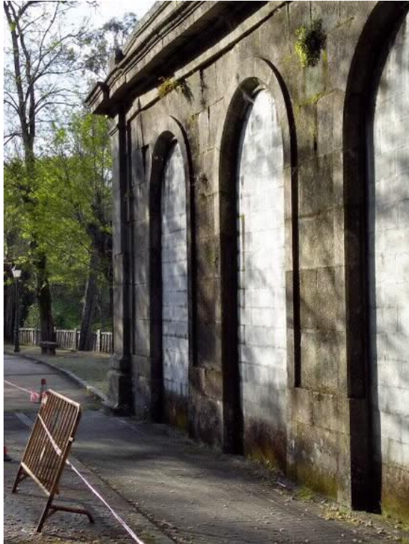
Parede lateral pos derrubamento 2019.
